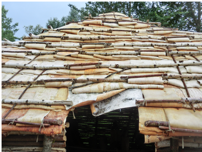
Bild 6: Haus der saisonalen Siedlung von Alleshausen-Grundwiesen mit alternativer Bedachung, Federseemuseum Bad Buchau
