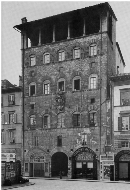
Palazzo Davanzati, Florenz Beispiel für einen spätmittelalterlichen Patrizierpalast. Heute Museum mit mittelalterlicher Inneneinrichtung. Ein Muss! Bild gemeinfrei | Vergrößern
