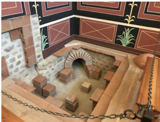
Römische Fußbodenheizung (Hypokaustanlage) in der Villa Borg, wie sie überall im Reich zu finden war. Die Bodenabdeckung ist abgenommen, damit man die Heizung sehen kann. Man bemerkt Säulchen und einen Tunnel, durch den Warmluft einströmte. Der Abzug kann manchmal durch Hohlziegel in den Seitenwänden erfolgen, der Austritt der Luft erfolgt dann etwa in Übermannshöhe aus der Wand ins Freie. Geheizt wurde mit Holz. Bild DEidG | Vergrößern
