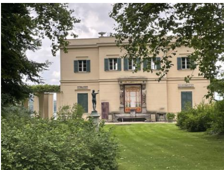
So sieht das Kasino durch eine Parksichtachse von vorne aus. Mittig über der Treppe befindet sich eine perspektivisch gehaltene Scheinarchitektur mit Scheinblick auf die Havel. Sehr raffiniert und eine neue Überraschung. Bild: DEidG | Vergrößern
