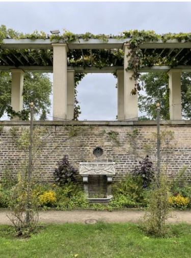
Bild 4 Schloss Charlottenhof , Stützmauer für die Laube
