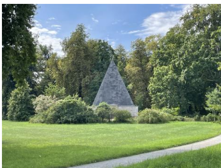
Die etwas entfernt im Park gelegene Pyramide, der Eiskeller des Marmorpalais. Die Schlossbibliothek war in einem gotischen Gebäude ausgelagert.
