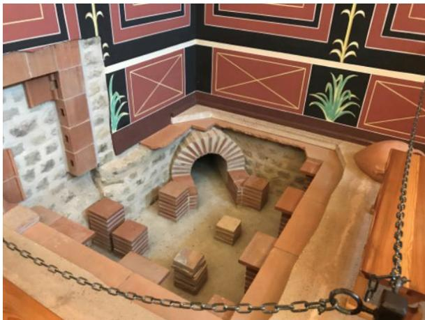
Römische Fußbodenheizung (Hypokaustanlage) in der Villa Borg, wie sie überall im Reich zu finden war. Die Bodenabdeckung ist abgenommen, damit man die Heizung sehen kann. Man bemerkt Säulchen und einen Tunnel, durch den Warmluft einströmte. Der Abzug kann manchmal durch Hohlziegel in den Seitenwänden erfolgen, der Austritt der Luft erfolgt dann etwa in Übermannshöhe aus der Wand ins Freie. Geheizt wurde mit Holz.
