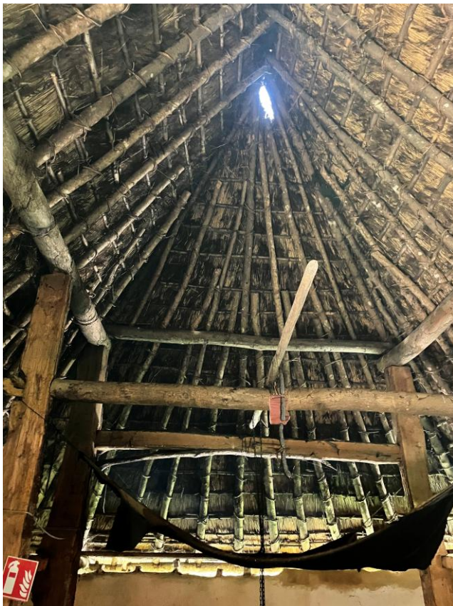
Alamannisches Wohnstallhaus: Blick in die Dachkonstruktion
