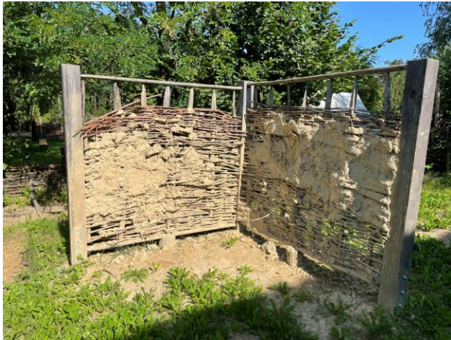
Alamannisches Wohnstallhaus: Bauweise der Wand
