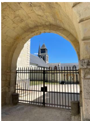
Bild 7: Tonnengewölbe im Eintrittsbereich von Kloster Fontevraud
