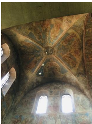
Bild 8: Kreuzrippengewölbe Braunschweiger Dom
