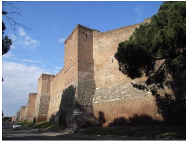
Rom, Aurelianische Mauer
