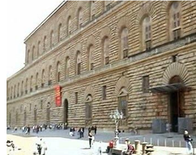
Palazzo Pitti, Frontseite
