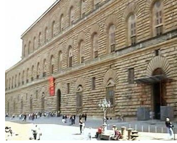
Palazzo Pitti, Frontseite mit Hof
