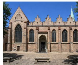
Dom: Seitenschiff von außen
