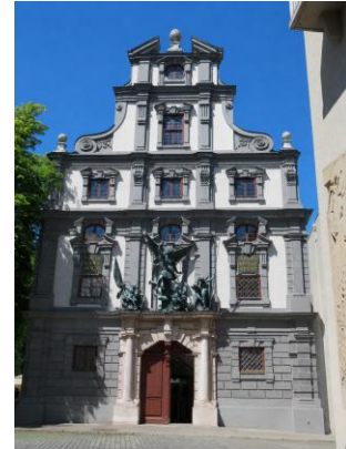
Fassade des Zeughauses, Augsburg. Abgebildeter Osttrakt 1602-7 von Elias Holl vollendet.
